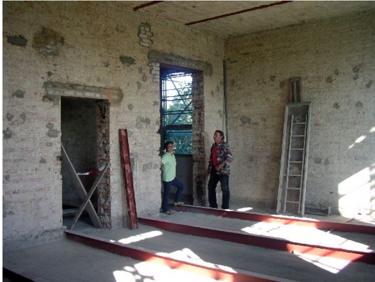
Bauarbeiten in der Alten Schule Karlshorst
