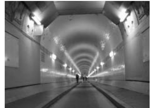
Der alte Elbtunnel als Überwachungsschleuse
